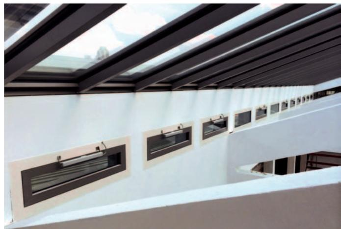
Dispositif pour tous types de châssis ouvrant en abattant et relevant intérieur/extérieur ouvrant à la Française ou à l'Anglaise.
